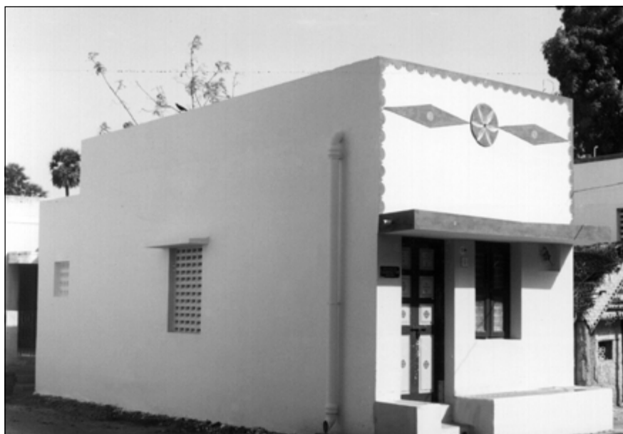
Abb. 2.: ... nach dem Neubau
