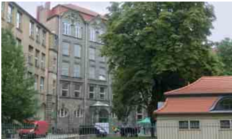
Die Marie-Elise-Kayser-Schule vor Beginn der Bauarbeiten
