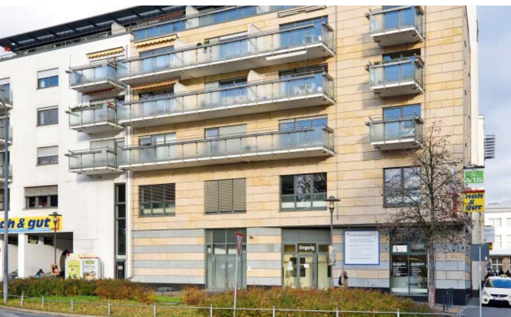
Neue Zahnklinik in der ersten und zweiten Etage an der alten Post Jena
