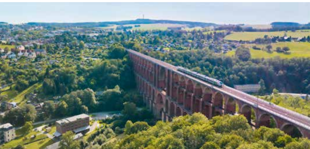
Die Göltzschtalbrücke im Vogtland ist die größte Ziegelsteinbrücke der Welt.
