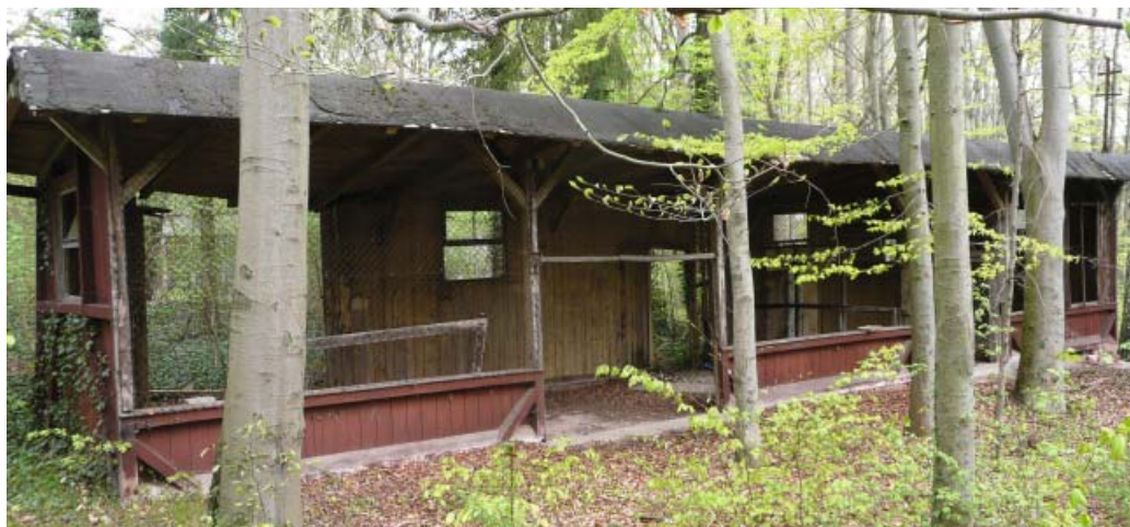
Originalteile der letzten Liegehalle wurden im Sommer 2017 abgebaut und gesichert.
