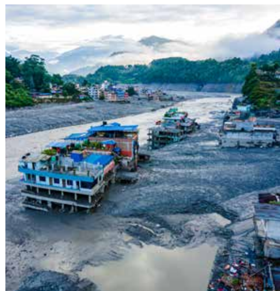
Massive Flutverwüstungen entlang des Flusses Bhote-Koshi
